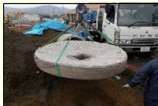
FRP防水をした本体
