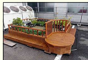
植栽・塗装を行いユニット完成
