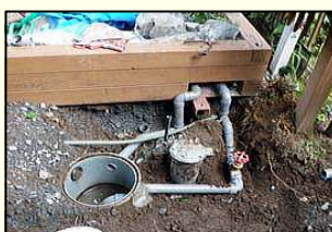
給水管・排水管接続
