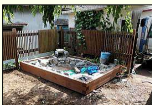
クレーンにて本体設置
