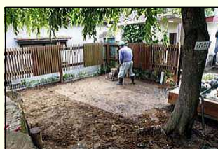
設置場所整地・転圧
