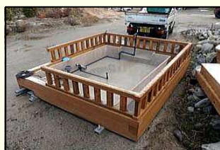
架台にFRP防水をした本体
