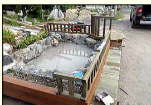
漏水テスト・アク抜き
